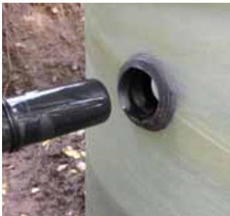
Rasvaa sähkötolpan läpivientikumi hyvin
