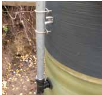
Asenna tolppa läpivientikumiin ja kiinnitä putki säiliöön
